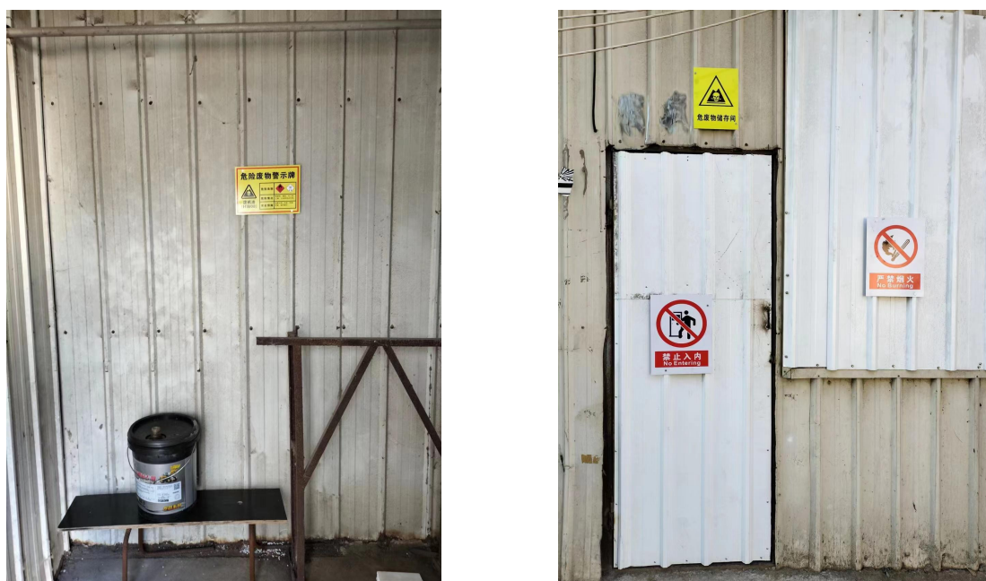
图 4-7 危废间内外部照片
